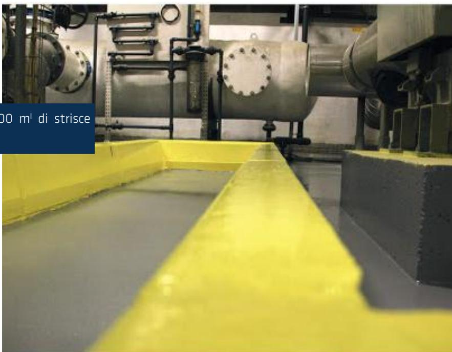
1.100 m<sup>2</sup> di pavimenti in colore Peltro con 100 m<sup>3</sup> di strisce segnaletiche e cordoli in colore Safety Yellow
